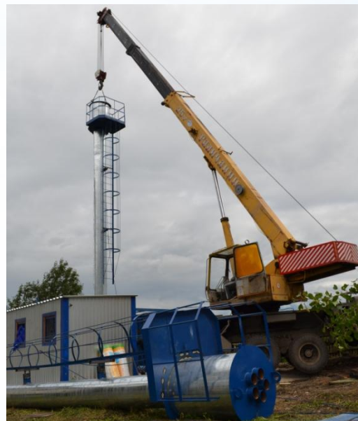
Установлена блочная модульная котельная в пос.Восход
